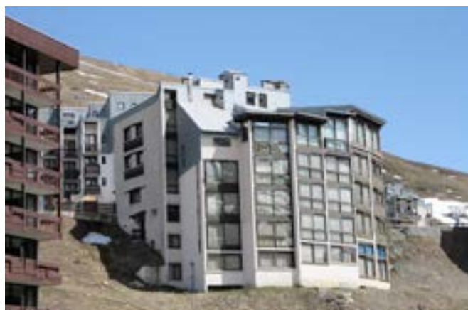
Façade arrondie vitrée tournée vers le paysage, CAUE, 2015
