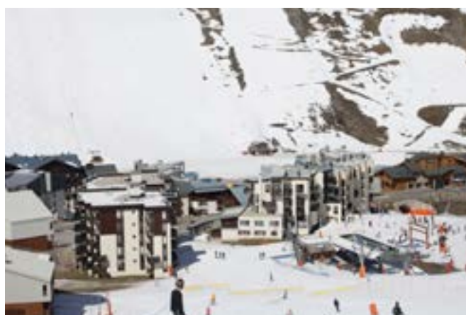
Vue d'ensemble des bâtiments, CAUE, 2015
