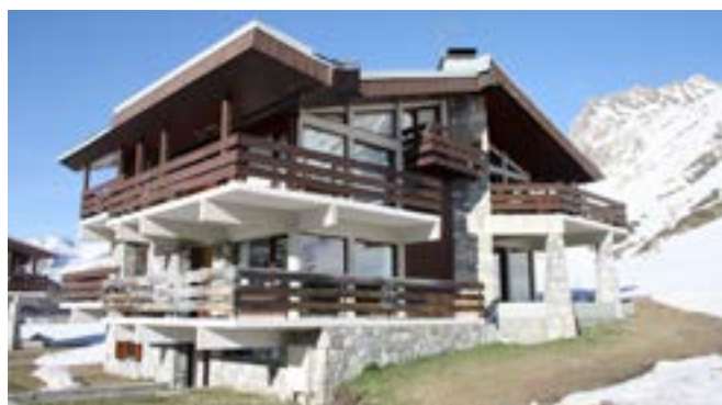
Soubassement en pierre, CAUE, 2015
