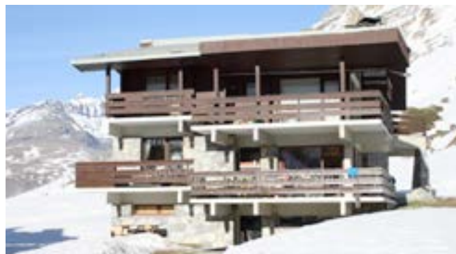
Larges ouvertures et balcons en bois, CAUE, 2015
