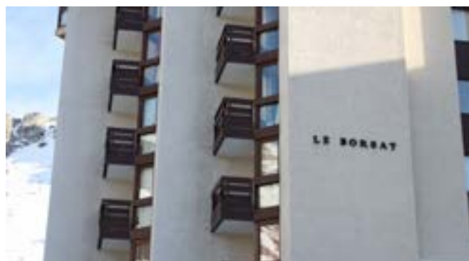
Contraste entre menuiserie et couleur de façade, CAUE, 2015
