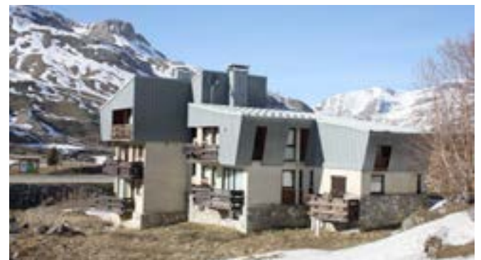
Le Cafetan et ses toitures métalliques, CAUE, 2015
