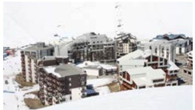
Des formes de toitures complexes, CAUE, 2015
