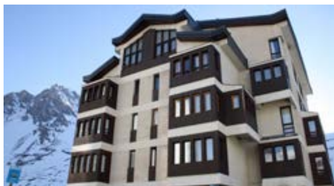
Bords de toiture retroussés, CAUE, 2015
