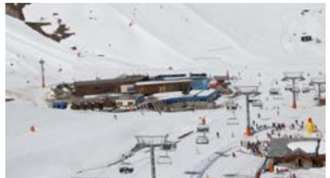
Vue depuis les pistes sur la toiture plate, CAUE, 2015
