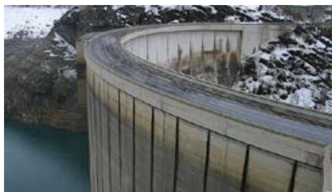
Barrage du Chevril à Tignes, CAUE, 2007
