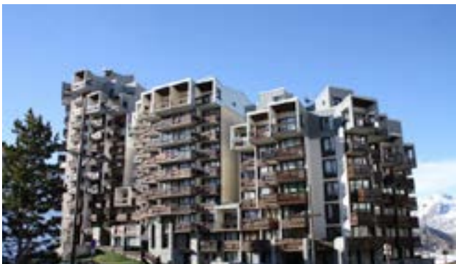
Façade à plusieurs pans, ouverte sur la montagne, CAUE, 2015
