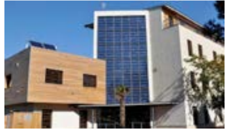
Mur rideau en panneaux photovoltaïques, Tanagra profil system, 2015
