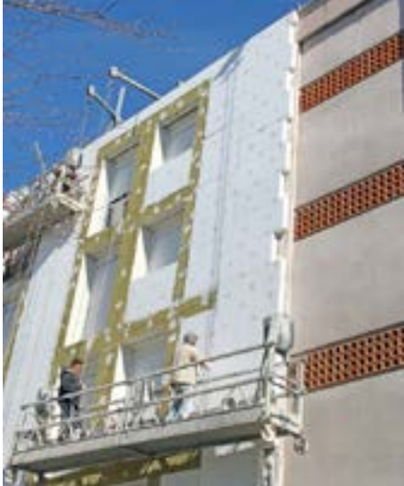
Isolation par l'extérieur d'une façade, Fotolia, 2015
