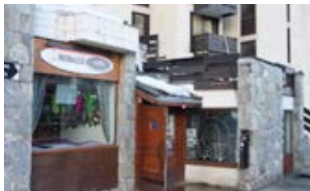
Entrée de commerce en pierre, CAUE, 2015
