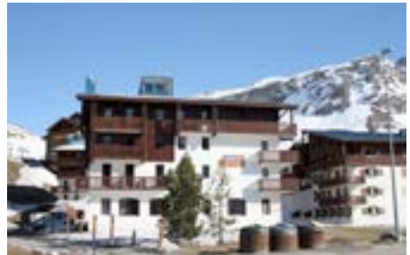
Absence de soubassement en pierre, chalets UCPA, CAUE, 2015
