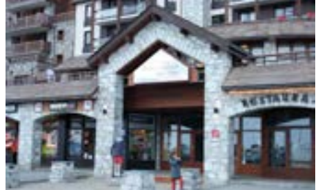
Soubassement en pierres au Diva, CAUE, 2015
