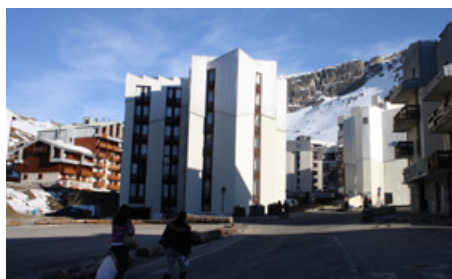
Un espace non aménagé et peu éclairé en pied de bâti, CAUE, 2015
