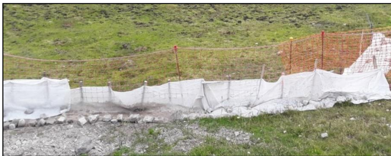
Exemple de textile filtrant mis en place pour retenir les boues
