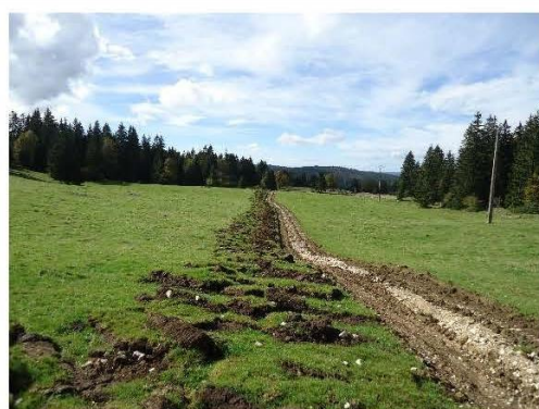
Stockage des mottes étrépees
