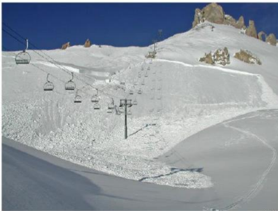
Photo d'une avalanche au niveau du point de tir PIDA 441 directement sous la ligne actuelle du TSF3 de l'Aiguille percée. Source ONF/RTM et Engineerisk.
