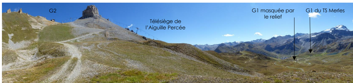
Vue depuis la piste d'accès à l'Aiguille Percée (source : Karum, 2022)
