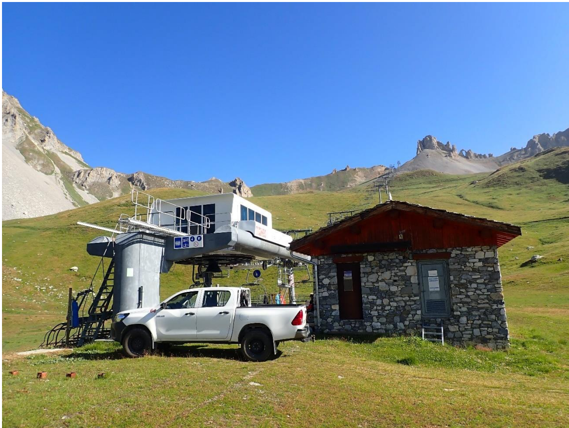
Photographie de la gare aval de l'Aiguille Percée qui sera démontée. Source KARUM (juillet 2022)
