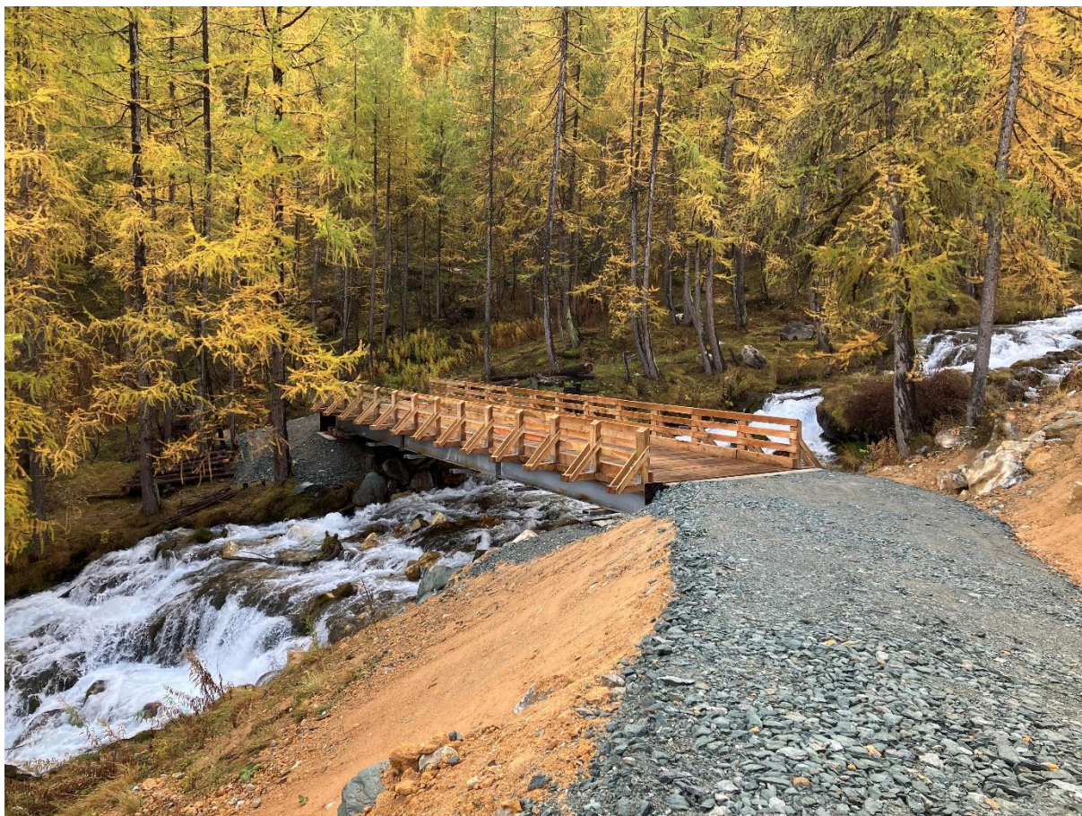
Figure 2 - Photo du pont routier supportant la canalisation depuis la centrale hydroélectrique des Combes (automne 2023)
