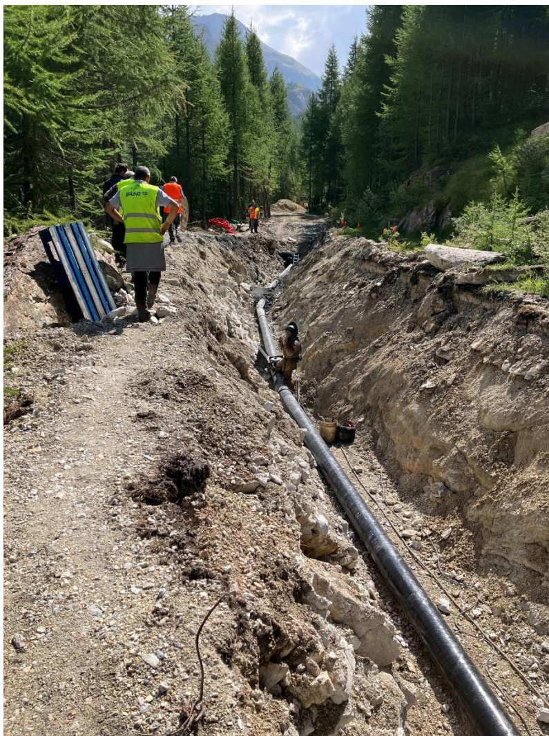
Figure 3 – Photo de pose et soudure des réseaux sur le sentier du Bois de la Laye (été 2024)
