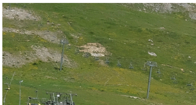
Engazonnement d'un enrochement de piste Jump Around - Juillet 2023
