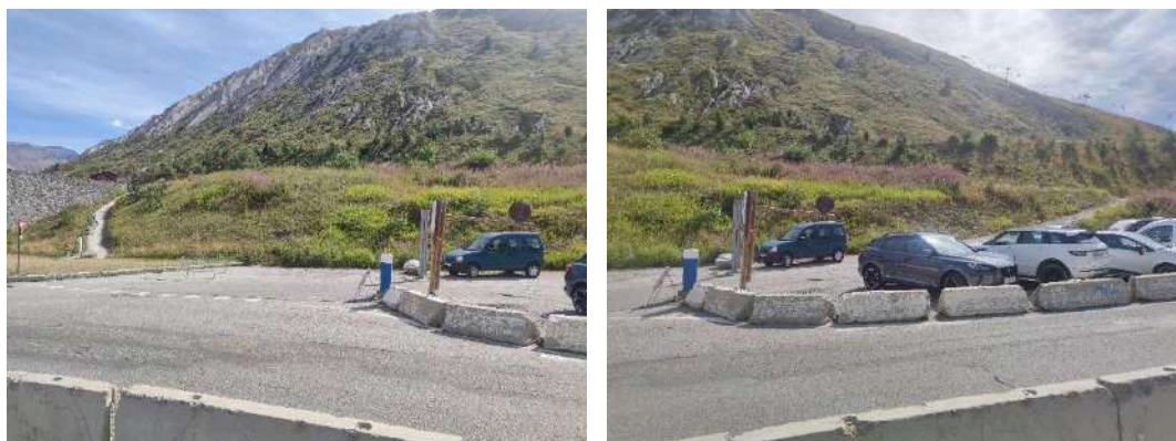
Vues de la partie Nord du site (visite du 24/08/2022)
