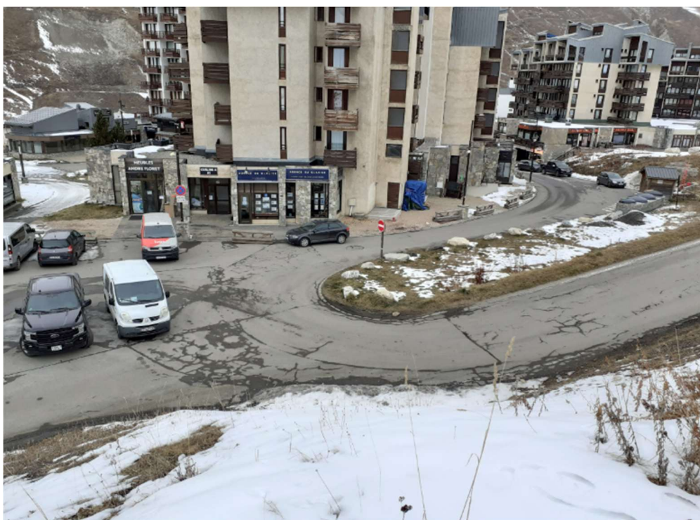
Photographie 12 : Accès au parking à l'ouest depuis la route du Golf
