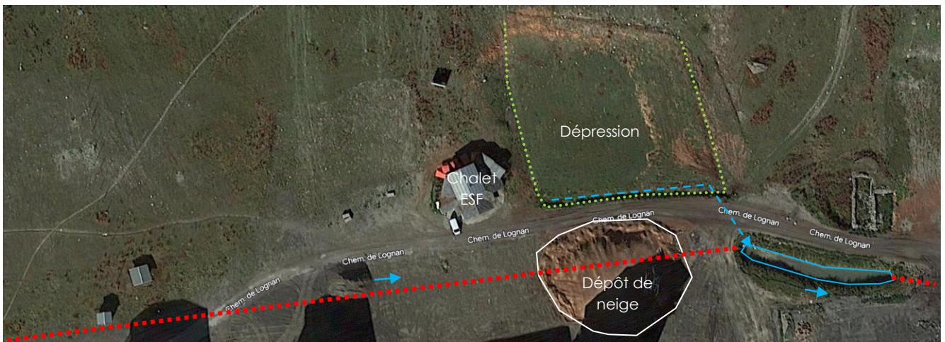
Figure 15 Vue aérienne du tronçon T3 (pointillés : section busée) (18.09.2022, google Earth)
