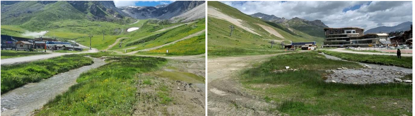
Figure 10 Vues du lit du Retort au niveau du tronçon T5, de l'étendue des formations végétales riveraines ainsi que des émergences de pied de versant rive gauche (photos biotec 04.07.2022)
