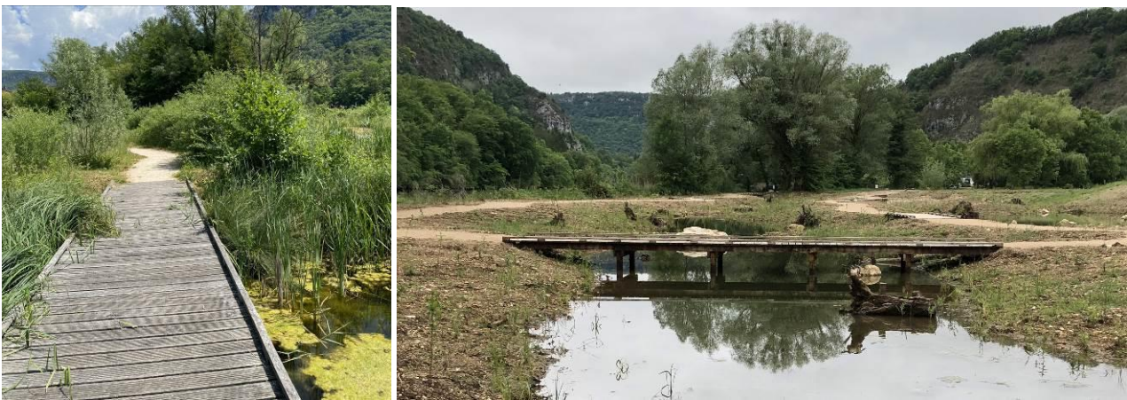
Figure 32 Exemple de cheminement piéton sur pilotis et platelage bois (source : Biotec, chantier de la lône de Thoirette (01))
