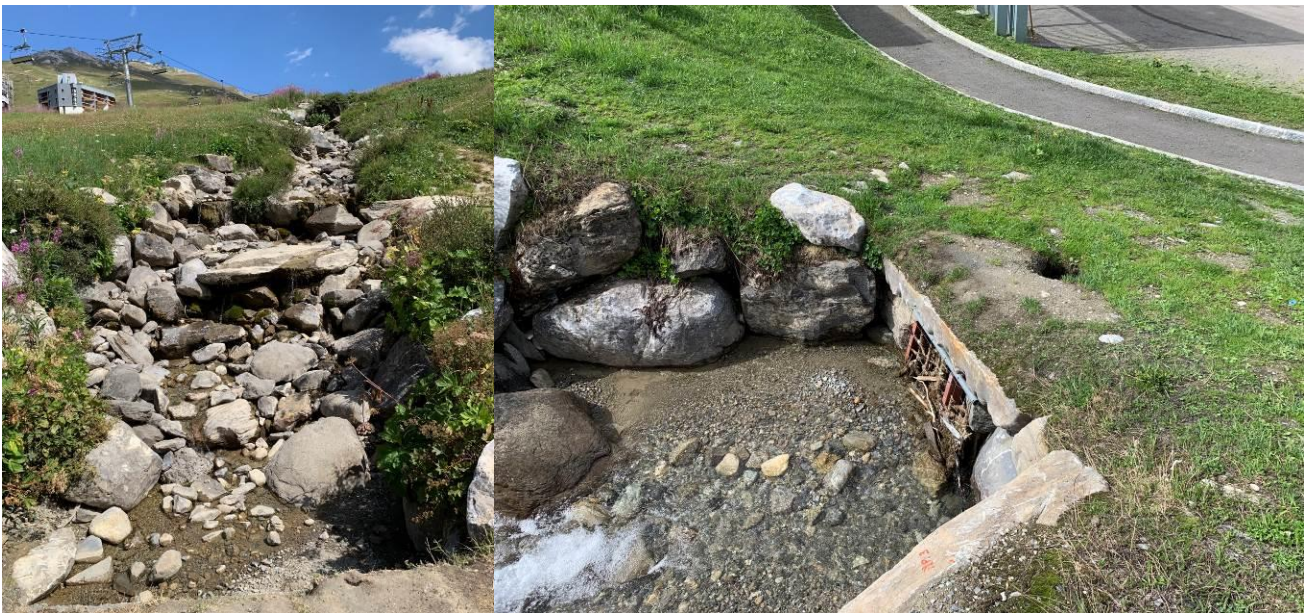
Figure 7 Vues de l'extrémité aval du torrent du Paquis et de l'entrée de la buse en pied de versant (photos biotec 04.07.2022 et 08.06.2022)
