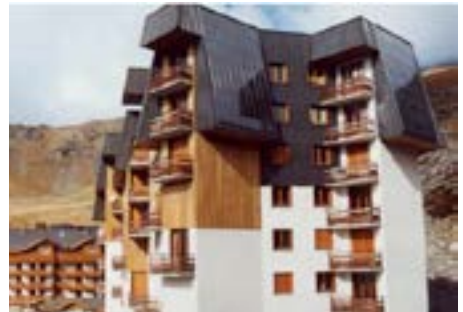
Production d'eau chaude solaire, immeuble le Gébroula, Val Thorens, ASDER, 2015
