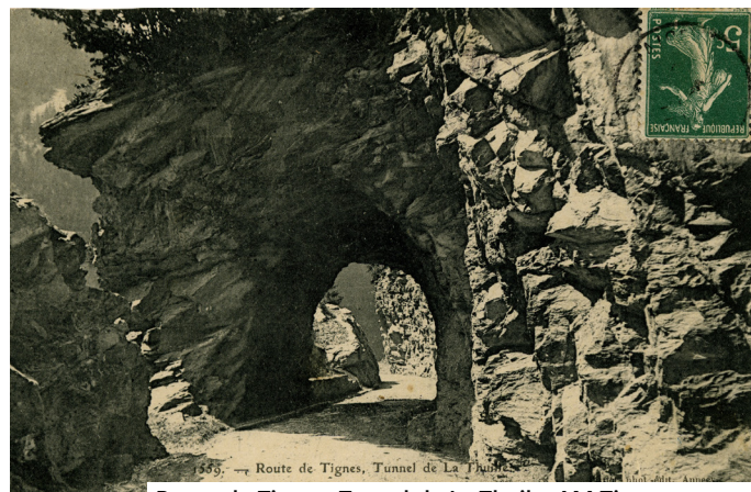
Route de Tignes, Tunnel de La Thuile, AM Tignes,
