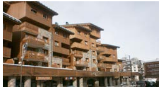
Le Nevada, entre pierre et bois ,CAUE, 2015
