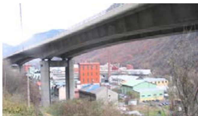
Nouvelle infrastructure de pont en vallée à Moûtiers, Charte architecturale Tarentaise-Vanoise, 2007
