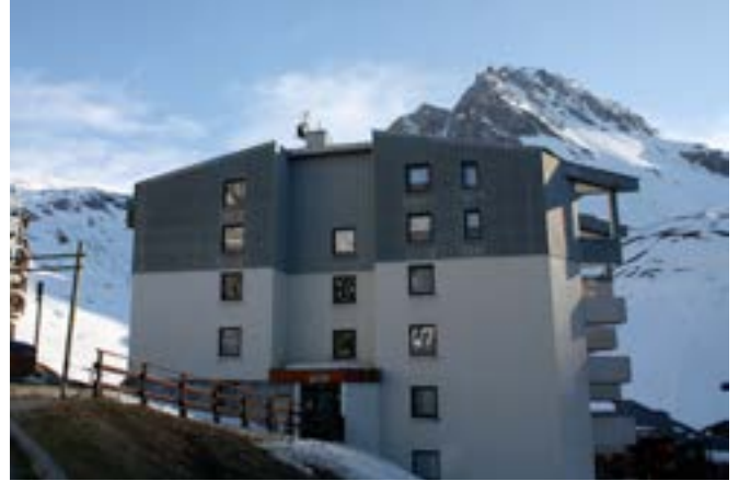
Façade opaque et couronnement métallique, CAUE, 2015
