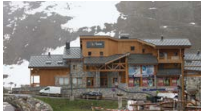
Le Jhana et ses façades en bois ,CAUE, 2015
