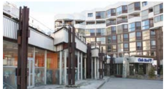
Cours donnant accès au bâtiment, CAUE, 2015
