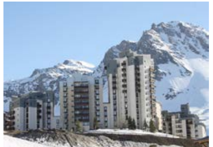
Toitures brisées et façades plurielles, CAUE, 2015
