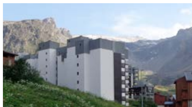
Façade nord opaque, CAUE, 2015
