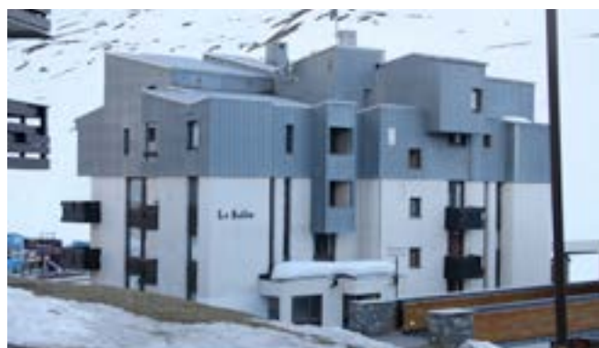
Le Bollin construit en 1988, reprend le même type de toiture de 1968-1969 imageant les massifs. CAUE, 2015
