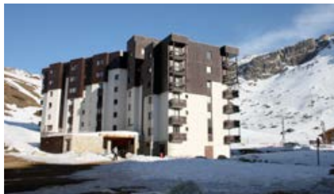
Les Tommeuses construit en 1980, utilise la toiture plate. CAUE, 2015
