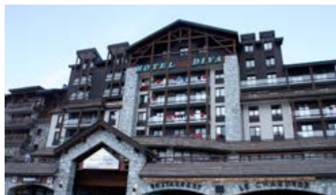
Le Diva construit en 1992, réintroduit des matériaux traditionnels tels que la pierre et le bois. CAUE, 2015
