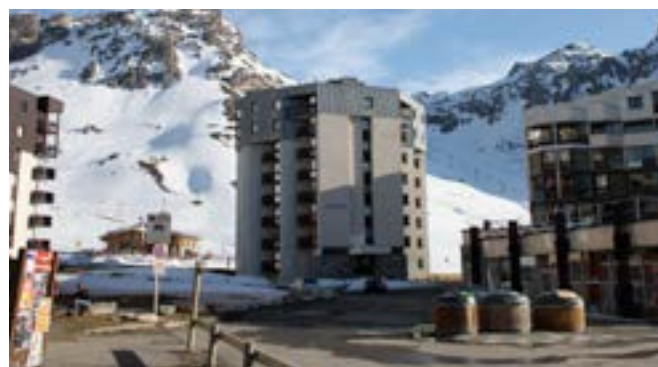
Couronne de métal marquant la toiture, CAUE, 2015
