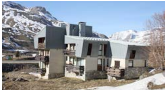
Le Cafetan et ses toitures métalliques, CAUE, 2015
