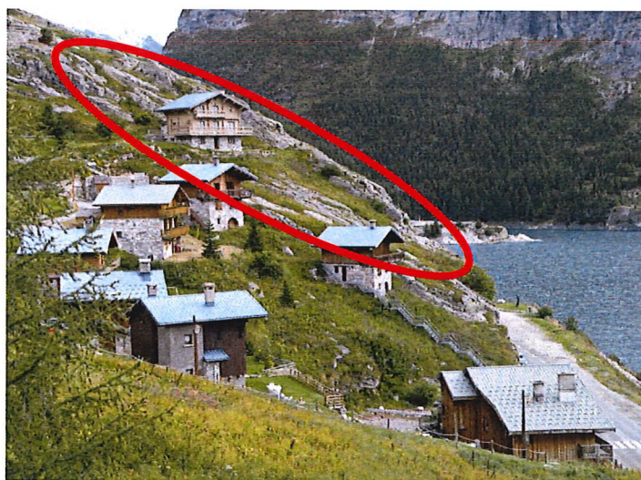
Fig. 12 : la zone à renseigner, vue de l'entrée nord du hameau.
