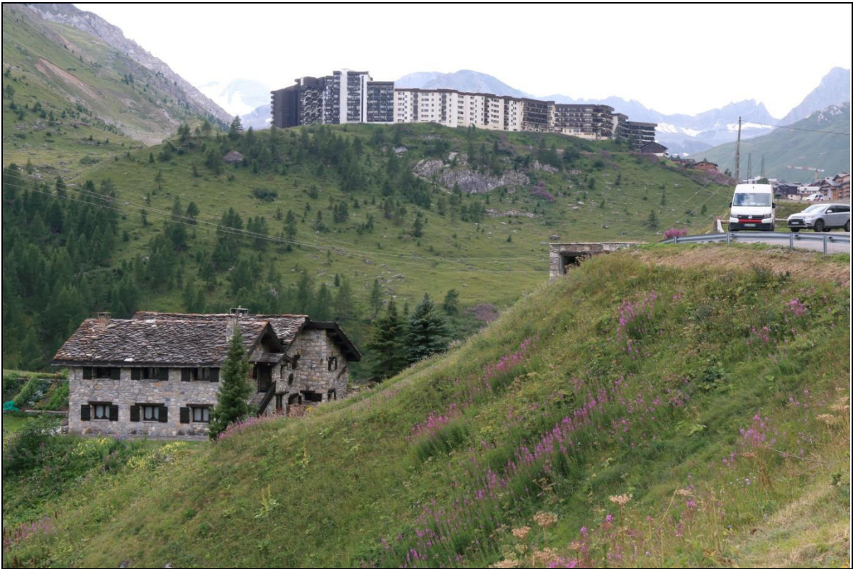
Photo 4. Le chalet de M. Revial et les garages situés au-dessus, juste en aval de la chaussée.
