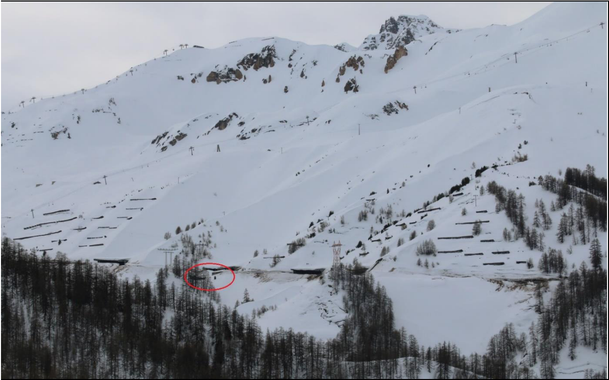
Photo 2. Localisation des bâtiments (entourés en rouge). Photo le 9 mars 2018.
