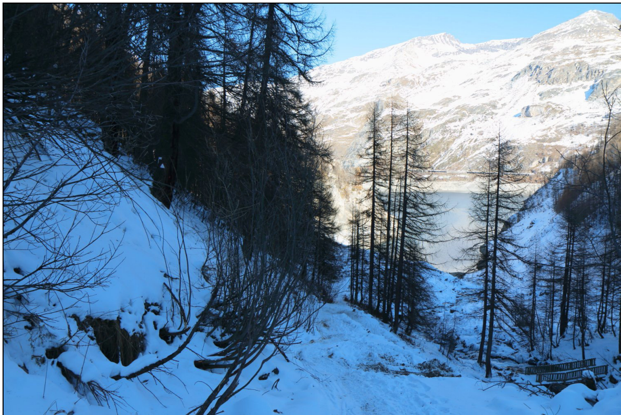
Photo 1. Implantation prévue pour la centrale hydro électrique (premier plan), en rive gauche du Ruisseau du Lac, en amont du petit pont (photo le 18 décembre 2017).
