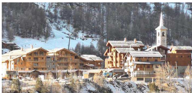
Photo 2 : Clocher de l'église des Boisses au milieu du nouveau complexe d'hébergement touristique Kalinda (Antea)
